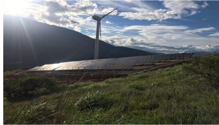
180 KW Rubessa, Bhutan.
